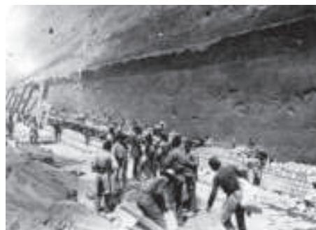
Изградња Коринтског канала
